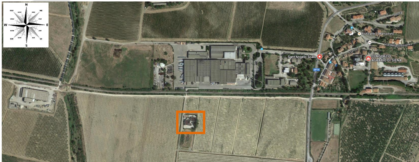
Figura 1: foto aerea dell'impianto di depurazione dell'azienda committente.
